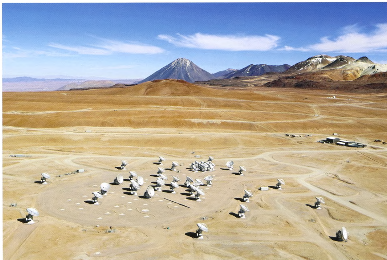
Figur 5. Luftfoto af antennerne på Llano de Chajnantor fra december 2012 fire måneder inden indvielsen af ALMA den 13. marts 2013. De mange trekantede flader er betonfundamenter, som antennerne anbringes på. De giver den mekaniske stivhed, som kræves til en præcis retningsindstilling, og de leverer elektrisk strøm og kølegas til driften samt dataforbindelse til AOS via optisk fiberkabel. Antennerne placeres af to specialkonstruerede køretøjer med en nøjagtighed på 2 mm. Midt i billedet ses en tæt gruppe på tolv 7-meter og fire 12-meter antenner. De udgør ALMA Compact Array , som bruges til iagttagelse af udstrakte objekter (molekyleskyer, nære galakser). Desuden kan tælles 32 af de i alt 66 store antenner på 12 m, der giver anlægget den store opløsningsevne. Til højre finder vi Technical Building , som rummer supercomputeren og beskedne faciliteter for ingeniører og andre medarbejdere. Man overnatter ikke her. I mellemgrunden ses det karakteristiske bølgede landskab dannet af sporadiske regnskyl mellem december og februar, hvor en jetstrøm kan skifte retning og sende fugtig luft ind østfra. Bagerst i billedet ser vi toppen af den imponerende stratovulkan Licancabur , hvis sne er næsten bortsmettet på dette sommerbillede. Foto: Clem & Adri Bacri-Normier/ESO.
