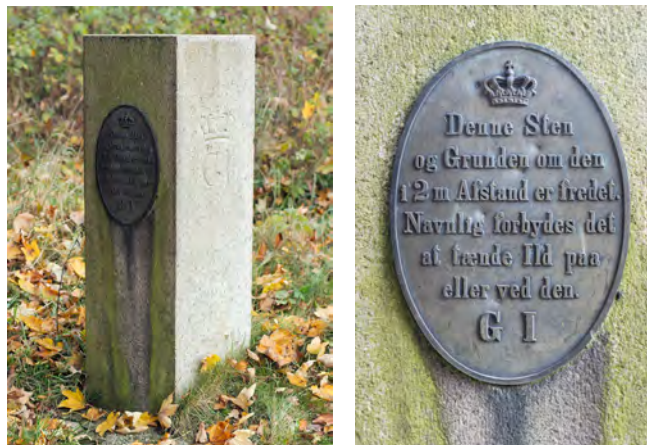
Figur 1. Postament for førsteordens punkter af granit ved Kongsbjerg / Lisbjerg nær Aarhus. Den synlige del rager ca. 1 m op over jordoverfladen og er forsynet med fredningsplade. Den underjordiske del er nedstøbt i et betonfundament på 1 \text{ m}^3 . Stationscentret er afmærket ved et hul i en messingbolt nedfæstet i stenens top. Foto: Wikipedia.
