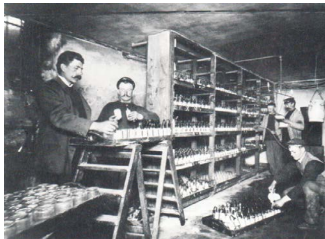
Figur 9. Batterikælderen i hovedtelegrafstationen i Købmagergade omkring 1895, hvor Leclancé-elementerne skulle vedligeholdes.
