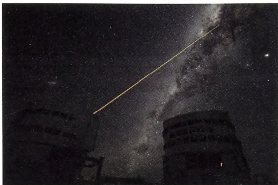
Figur 7. Laserguidestjerne anvendt til observation af Mælkevejens centrum ved brug af adaptiv optik (ESO).
