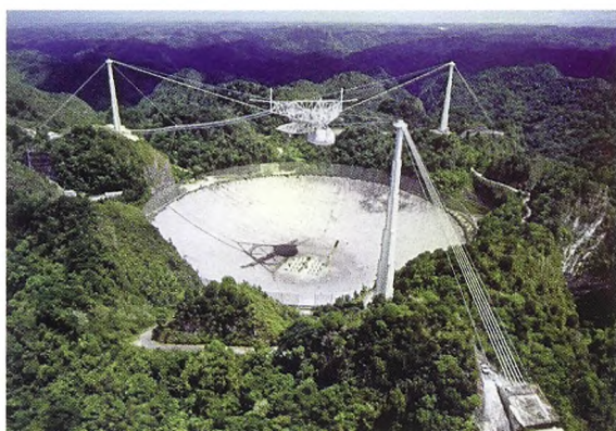
Figur 2. Det store Arecibo teleskop på Puerto Rico. Selve antennen er 305 m i diameter og fast monteret på Jorden. Teleskopet kan derfor ikke dække hele himlen (Ill: NAIC).
