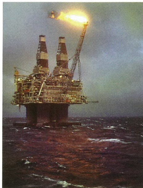
Figur 2. Produktionsplatform til søs som afbrænder ("flare") naturgas, der kommer op sammen med olien. Copyright: Straylight Pictures.
