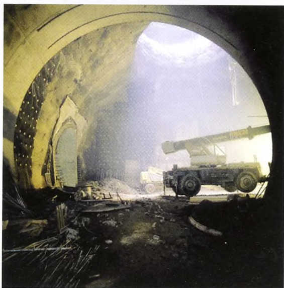
Figur 6. LEP tunnelen under udboring. Den stod færdig i 1988. Tunnelprojektet var Europas største og udført med uhørt præcision. Tunnellen husede LEP acceleratoren i 12 år og blev herefter overtaget af LHC acceleratoren (CERN).
