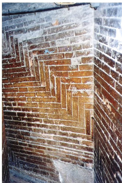
Figur 11. Fiskebensmønstret i kuplens murværk som det ses i opstigningspassagen mellem de to kuppelskaller.
