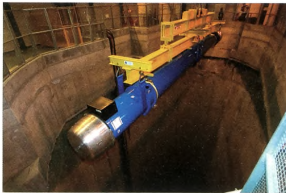
Figur 2. En 15 m lang, 27 tons tung dipol-magnet sænkes ned gennem en af adgangsskakterne til LHC-tunnelen 100 m nede.
